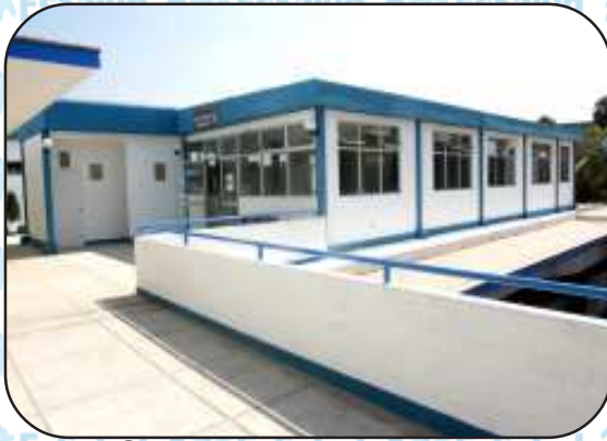
Servicio de Emergencia
