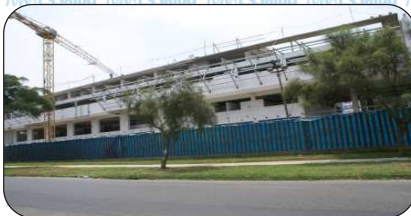
Avances obras INCOR
