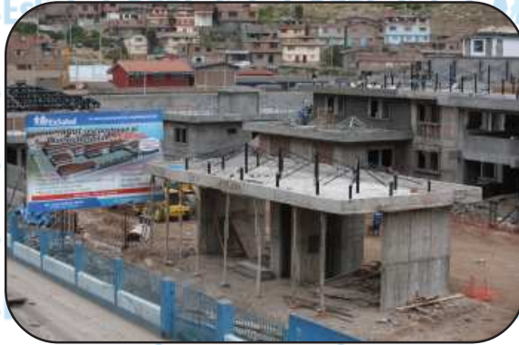
Nuevo Hospital La Oroya
