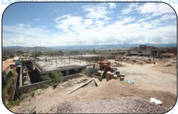
Nuevo Hospital Huamanga
